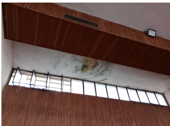
Zona de cielorraso donde se producen las filtraciones y goteras
