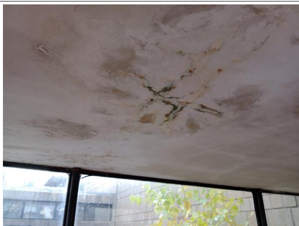
Revoque de cielorraso afectado por filtraciones en puente acceso.
