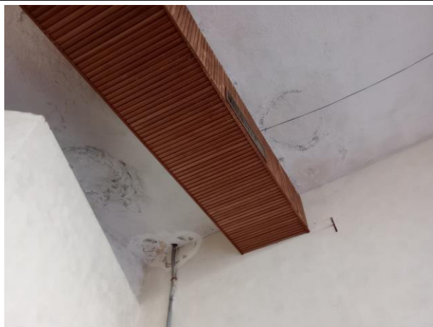
Revoque de cielorraso afectado por filtraciones en puente acceso.
