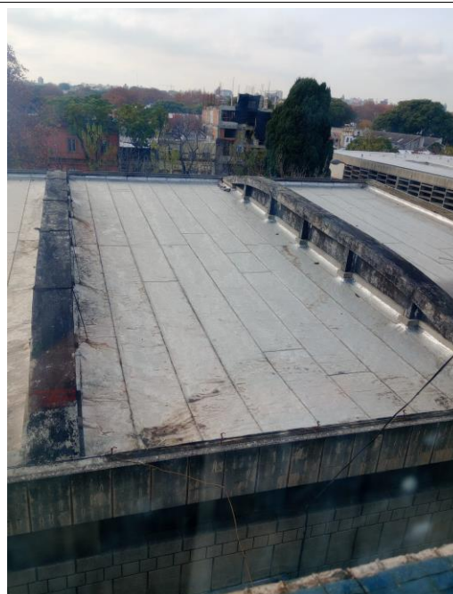
Vigas invertidas existentes
