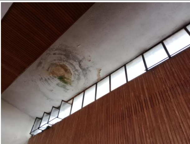
Se considera reparación y pintura de faja de cielorraso entre fachada y viga revestida en madera
